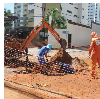
Caern vai substituir rede de amianto por PVC
